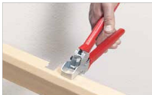
Рис. 16-39 Вырезка прямоугольных отверстий в крышке плинтусных каналов
