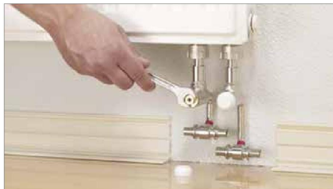
Рис. 16-45 Затяжка резьбозажимного соединения
