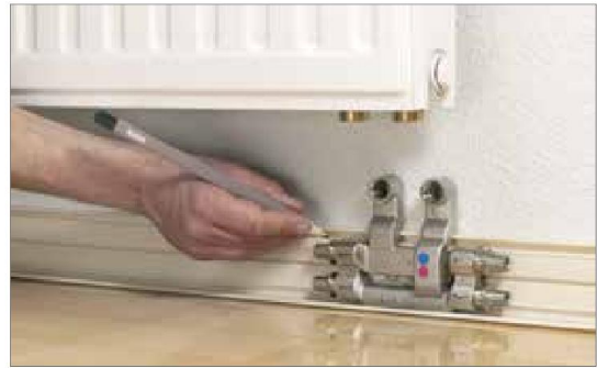
Рис. 16-32 Определение длины трубы
