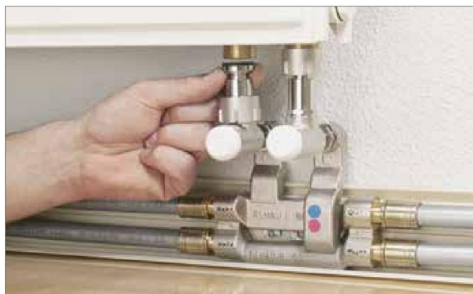
Рис. 16-26 Подключение угловых телескопических резьбозажимных соединений
