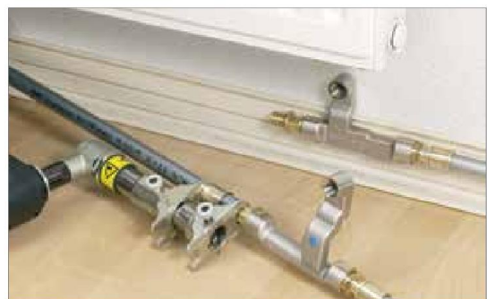
Рис. 16-34 Соединение с помощью подвижной гильзы, трубы диаметром 16 мм с крестовиной SL RAUTITAN из комплекта
