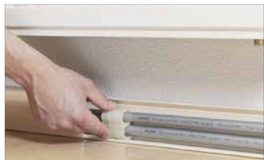
Рис.16-36 Установка фиксаторов труб отопительной разводки
