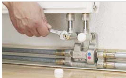
Рис. 16-38 Прочно затяните резьбозажимное соединение.
