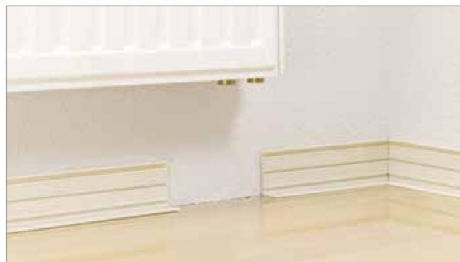
Рис. 16-42 Установленное основание плитусного канала RAUSOLO с выемкой
