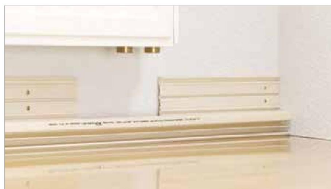
Рис. 16-43 Установленное основание плитусного канала RAUDUO с выемкой
