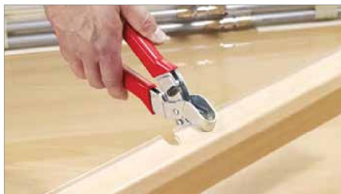
Рис.16-46 Вырезка полукруглых отверстий в крышке плинтусного канала
