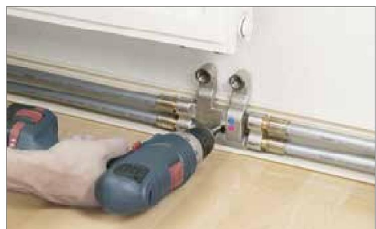
Рис. 16-35 Закрепление крестовины SL-RAUTITAN
