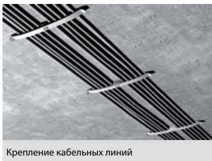
Крепление кабельных линий
