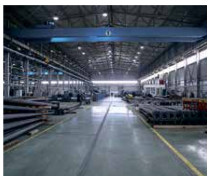
г. Тула, Завод "ОПОРА ИНЖИНИРИНГ"
